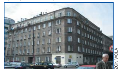
Budynek przy ul. Ogrodowej 56 przed i po remoncie.
