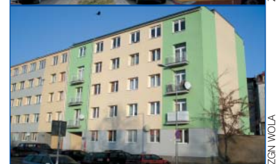
Budynek Krzyżanowskiego 42 przed i po wykonaniu ocieplenia.
